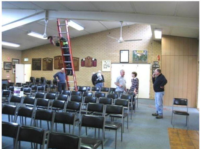
Neil cleaning the fan blades
